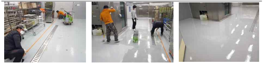
바닥 에폭시 코팅 작업
