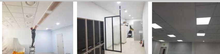
인재경영팀 내부 확장 공사
