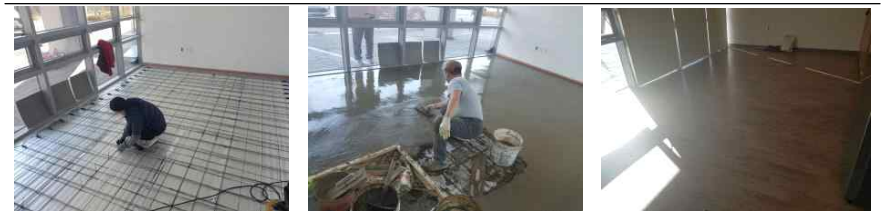
전기 온돌 설치 작업
